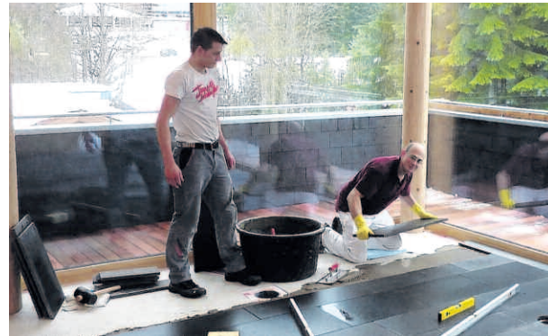
Der Weilerswister Fliesenleger beim Verlegen der Basaltplatten.
