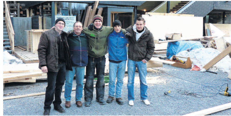
Thomas Abts (links) mit seinen Mitstreitern auf der Baustelle in Whistler. Fotos:privat
